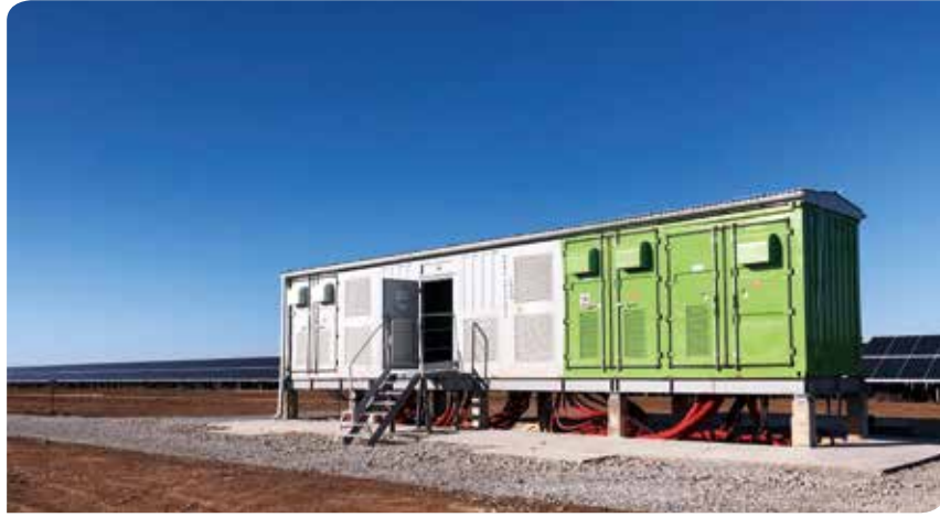
俄罗斯118.5MW Avelar 光伏项目
