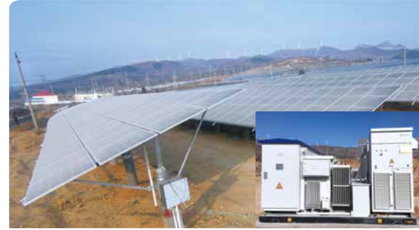
山西运城芮城南卫82MW光 伏项目
