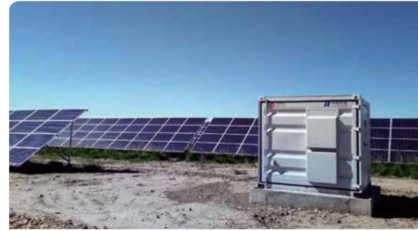
河北华能康宝西滩20MW 光伏电站
