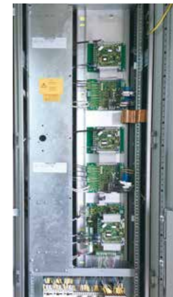
改造后：禾望控制系统单板
