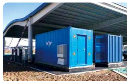
> 北京某机场储能电站项目 500kW/1.1MWh
