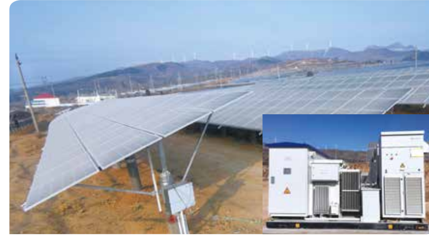
山西运城芮城南卫82MW光 伏项目
