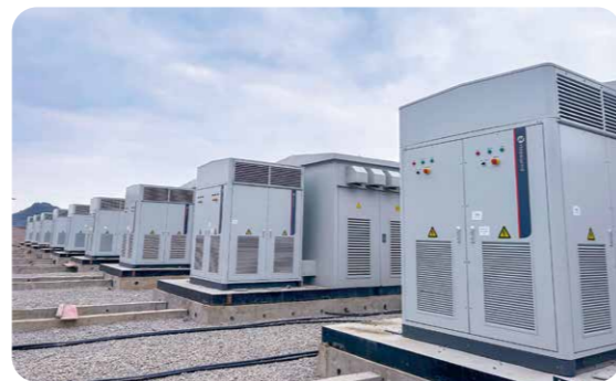
> 贵州安顺100MW/200MWh储能项目
