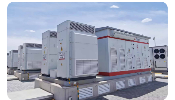
> 宁夏中卫160MW/320MWh光储项目
