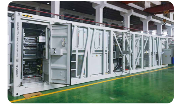
> 西班牙45MW/180MWh光伏配储项目
