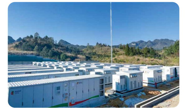
> 贵州黔南100MW/200MWh独立储能项目
