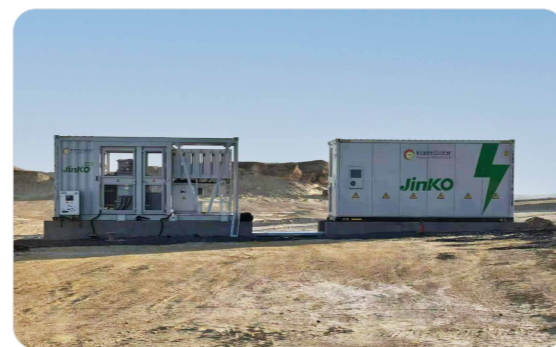
> 埃及1.25MW/2.5MWh工商业光伏配储项目
