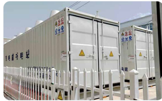
> 浙江长兴3MW/31MWh铅炭电池储能电站项目
