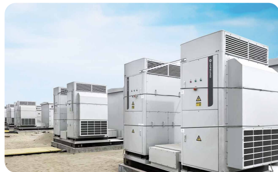
> 新疆喀什50MW/100MWh构网型储能项目
