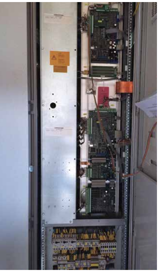
改造前：国外K品牌变流器控制单板
