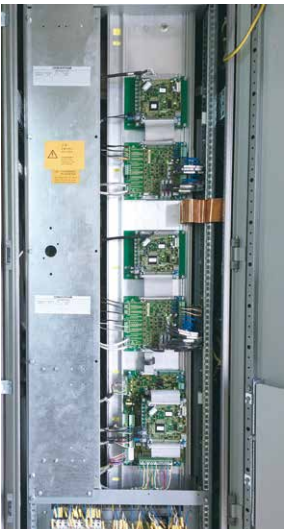
改造后：禾望控制系统单板
