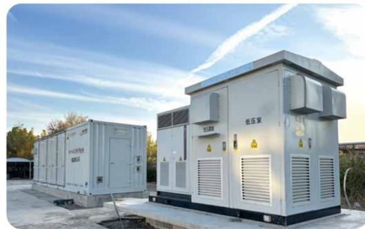
> 天津市大港油田1MW/1MWh钠离子电池储能电站
