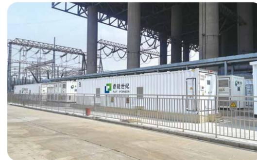
> 山西15MW/7.5MWh发电厂火储联合调频项目
