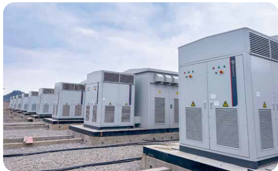
> 贵州安顺100MW/200MWh储能项目
