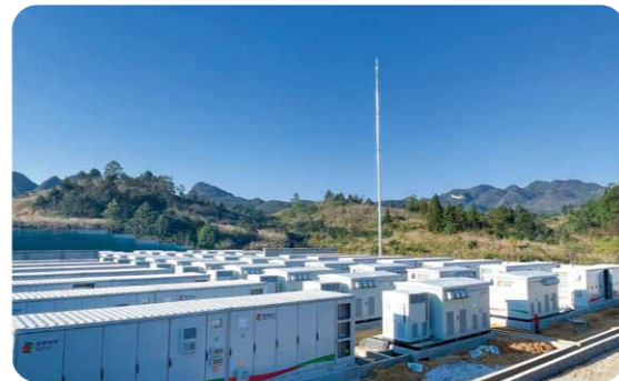
> 贵州罗甸100MW/200MWh储能项目
