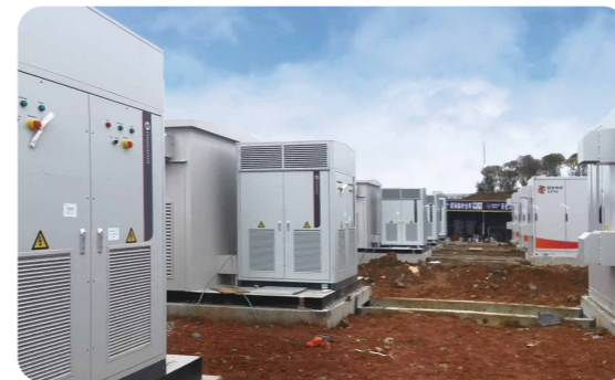
> 贵州瓮安100MW/200MWh储能项目
