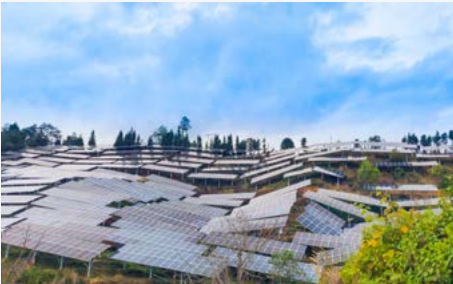
云南临沧 300MW 光伏复合项目现场图
